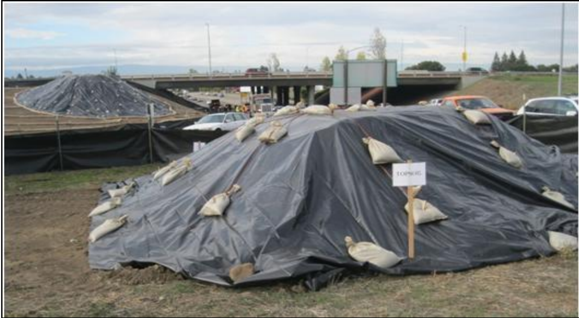
Εικόνα 9: Παράδειγμα κάλυψης μπαζών / αδρανών
