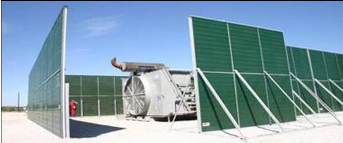
Εικόνα 8: Παράδειγμα χρήσης ηχοπετασμάτων σε σταθερές πηγές θορύβου
