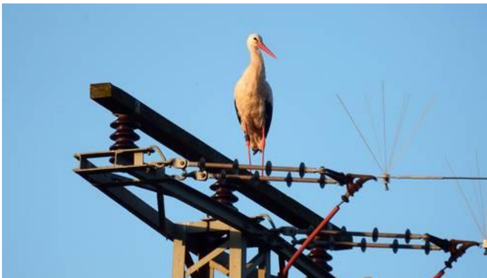
Εικόνα 11: Εφαρμογή μέτρου μείωσης του κινδύνου θνησιμότητας των πτηνών από προσκρούσεις στα καλώδια μεταφοράς ρεύματος
