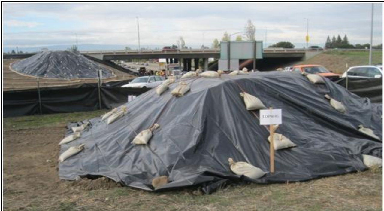
Εικόνα 14: Παράδειγμα κάλυψης μπαζών / αδρανών
