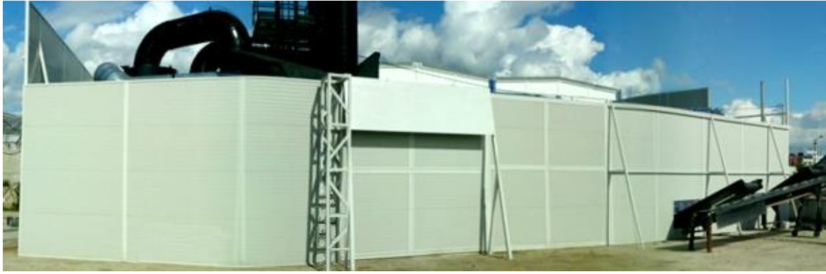
Εικόνα 6: Παράδειγμα χρήσης ηχοπετασμάτων σε σταθερές πηγές θορύβου
