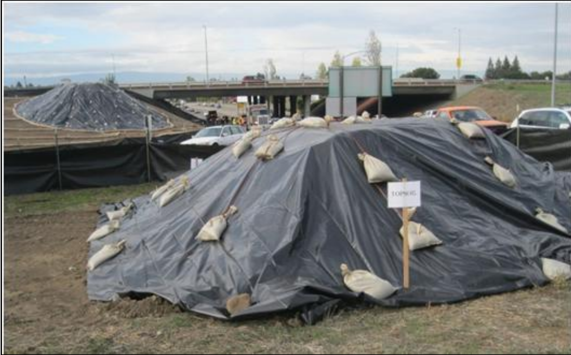
Εικόνα 7: Παράδειγμα κάλυψης μπαζών / αδρανών
