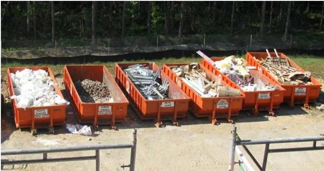
Εικόνα 9: Παράδειγμα συλλογής και διαχωρισμού αποβλήτων
