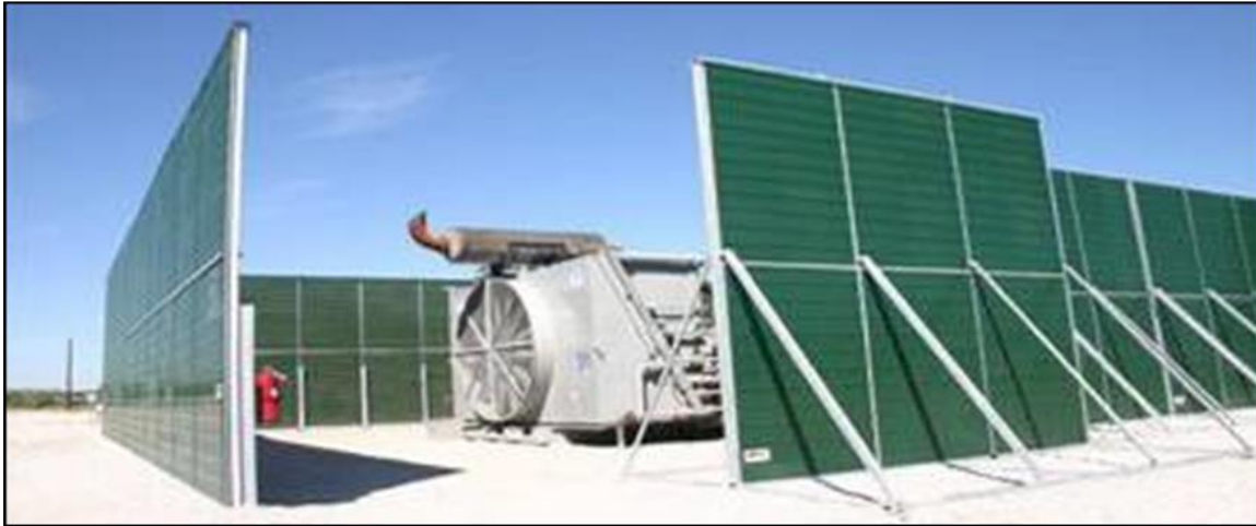
Εικόνα 7: Παράδειγμα χρήσης ηχοπετασμάτων σε σταθερές πηγές θορύβου
