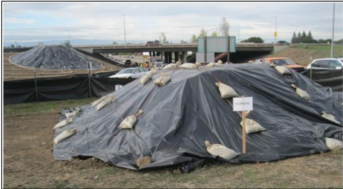
Εικόνα 8: Παράδειγμα κάλυψης μπαζών / αδρανών
