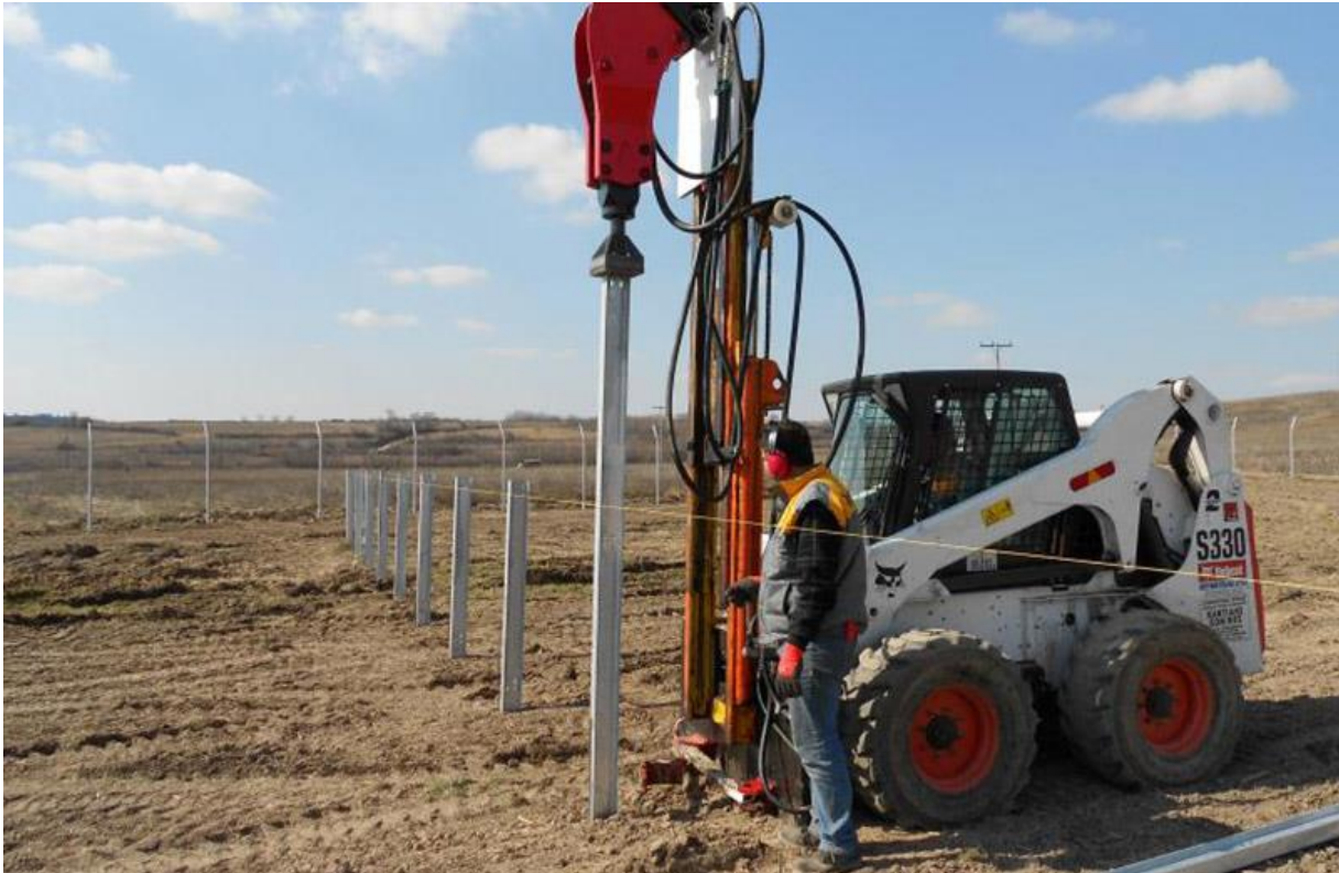
Εικόνα 4-6: Αυτοκινούμενο μηχάνημα τοποθέτησης πασσάλων Φ/Β Πλαισίων
