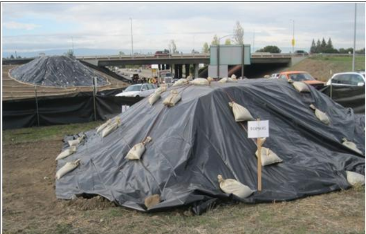
Εικόνα 8-2: Παράδειγμα κάλυψης μαζών στο εργοτάξιο
