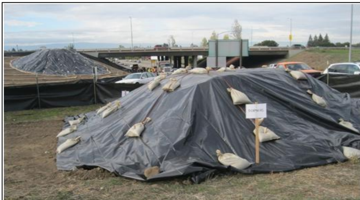
Εικόνα 8: Παράδειγμα κάλυψης μπαζών/ αδρανών
