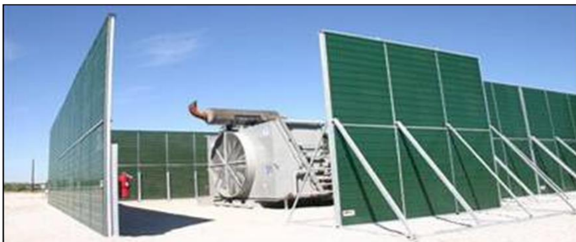
Εικόνα 7: Παράδειγμα χρήσης ηχοπετασμάτων σε σταθερές πηγές θορύβου
