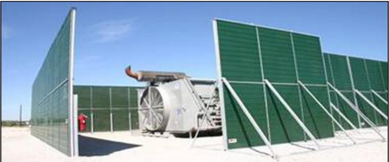
Εικόνα 7: Παράδειγμα χρήσης ηχοπετασμάτων σε σταθερές πηγές θορύβου
