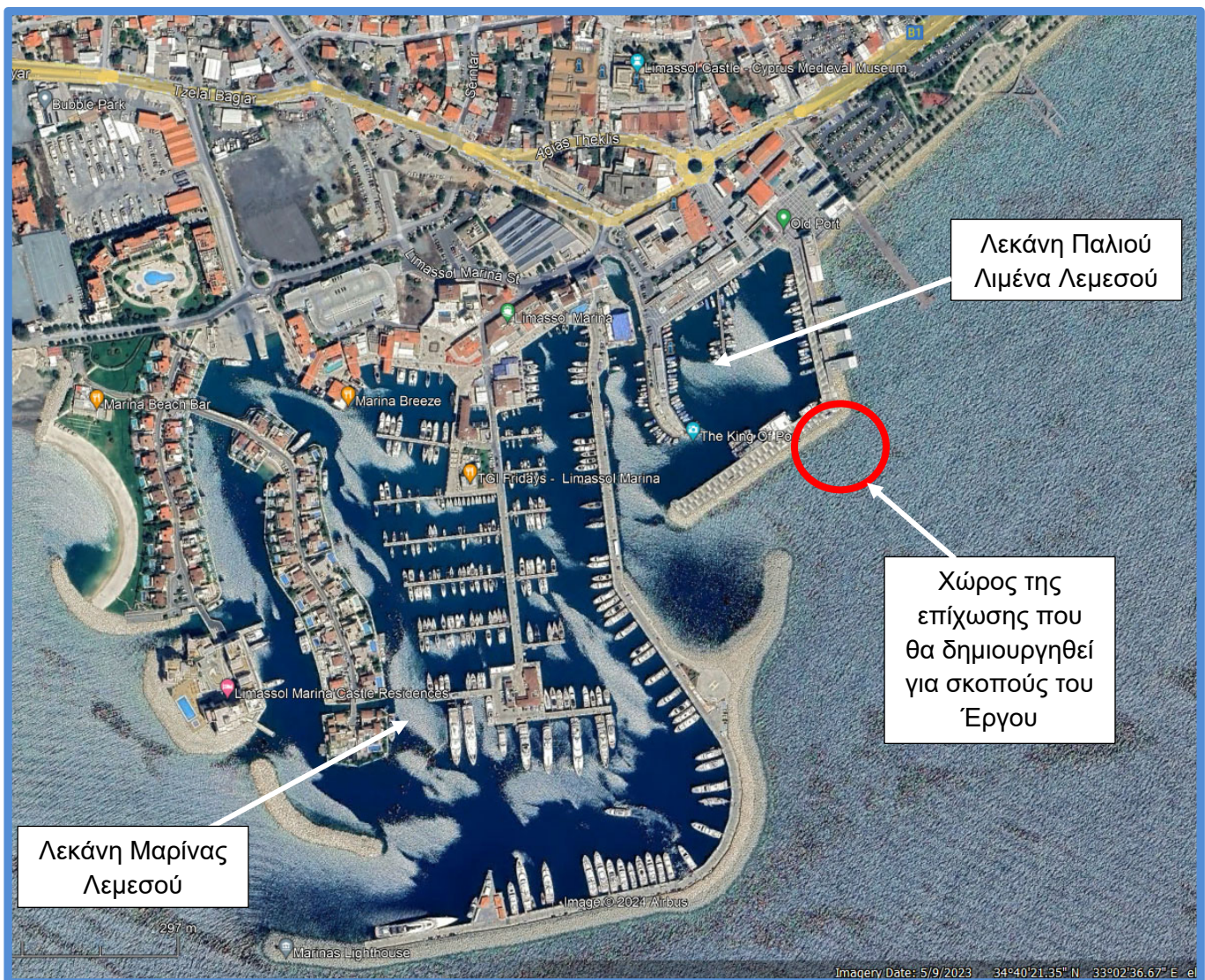
Εικόνα 1: Περιοχή Επίχωσης που θα Φιλοξενήσει το Έργο
