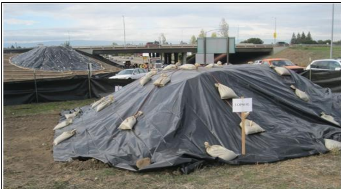
Εικόνα 7: Παράδειγμα κάλυψης μπαζών / αδρανών
