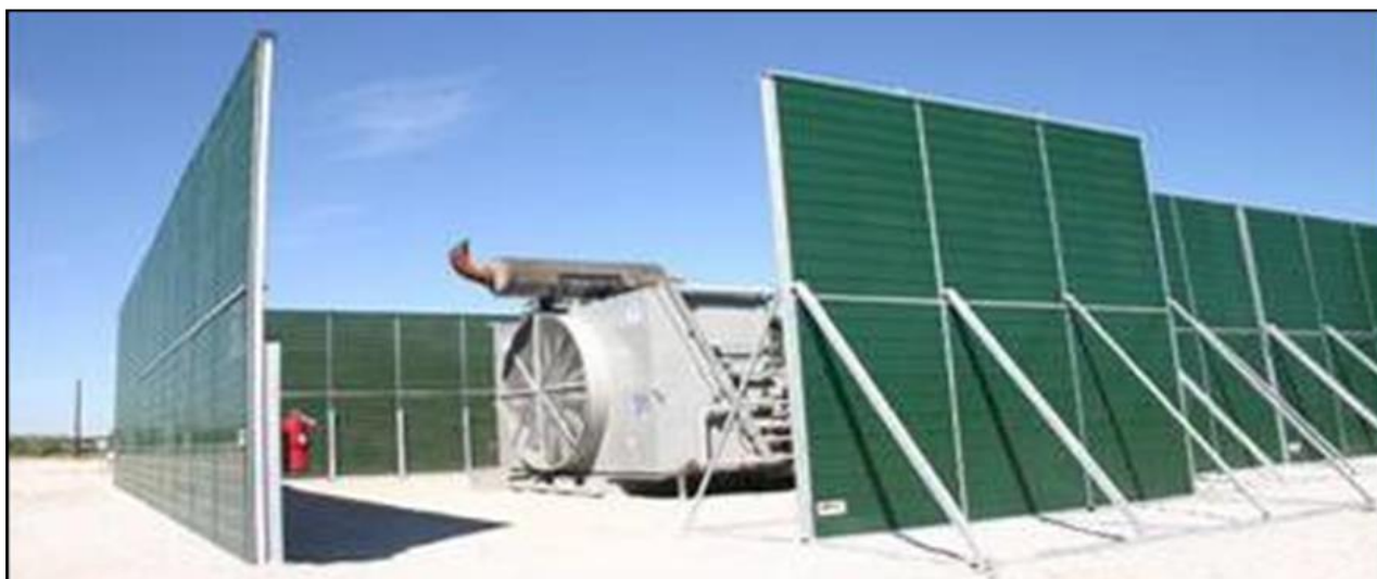
Εικόνα 7: Παράδειγμα χρήσης ηχοπετασμάτων σε σταθερές πηγές θορύβου
