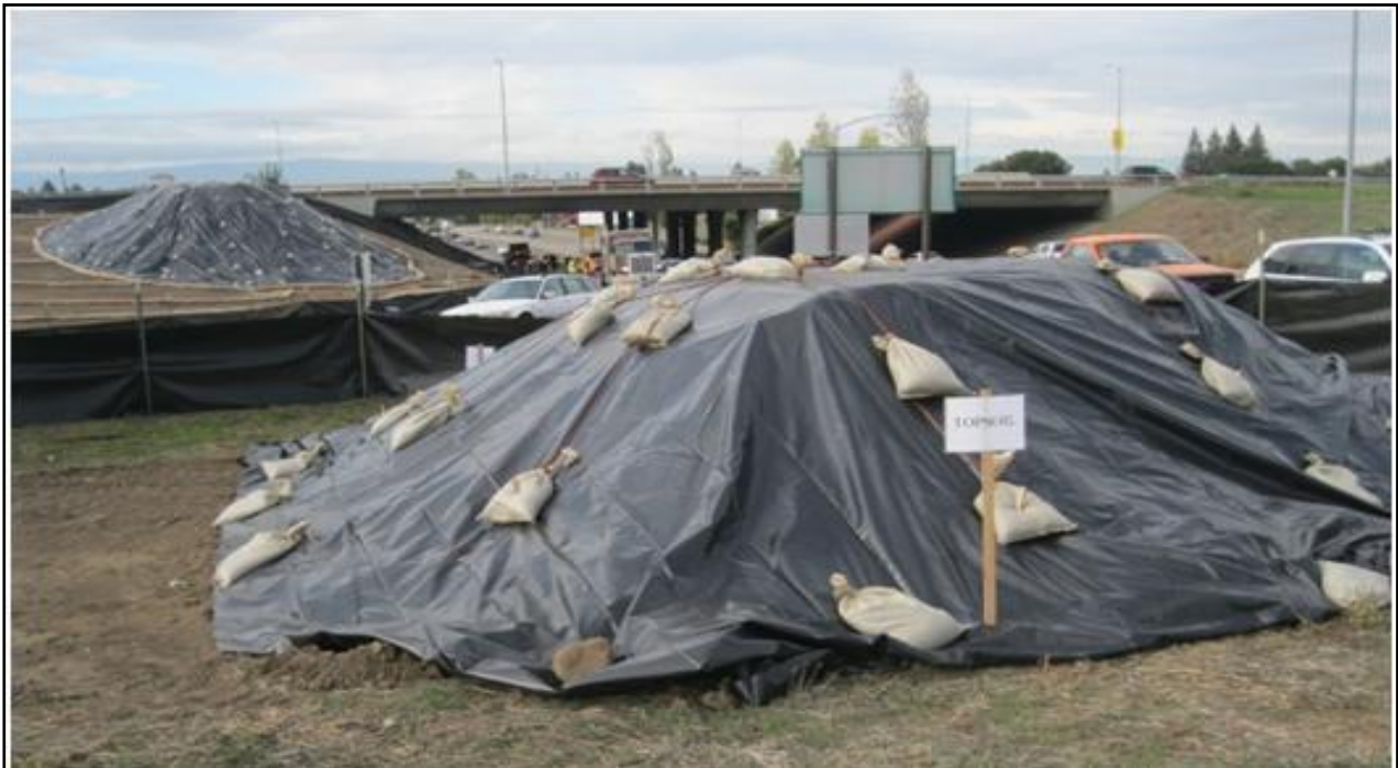
Εικόνα 8: Παράδειγμα κάλυψης μπαζών / αδρανών
