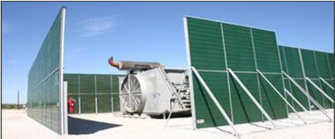
Εικόνα 7: Παράδειγμα χρήσης ηχοπετασμάτων σε σταθερές πηγές θορύβου
