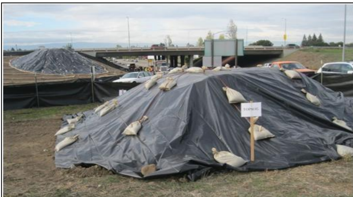
Εικόνα 6-2: Παράδειγμα κάλυψης μπαζών / αδρανών
