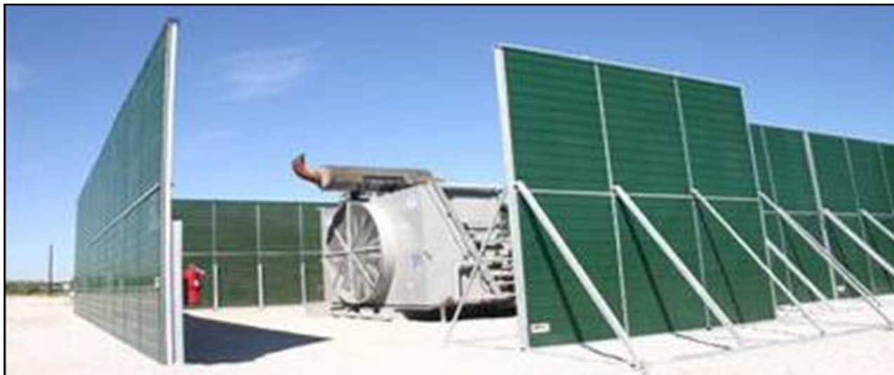
Εικόνα 7: Παράδειγμα χρήσης ηχοπετασμάτων σε σταθερές πηγές θορύβου
