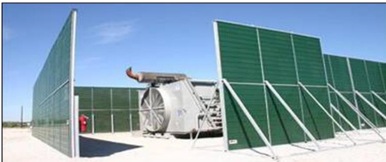
Εικόνα 7: Παράδειγμα χρήσης ηχοπετασμάτων σε σταθερές πηγές θορύβου
