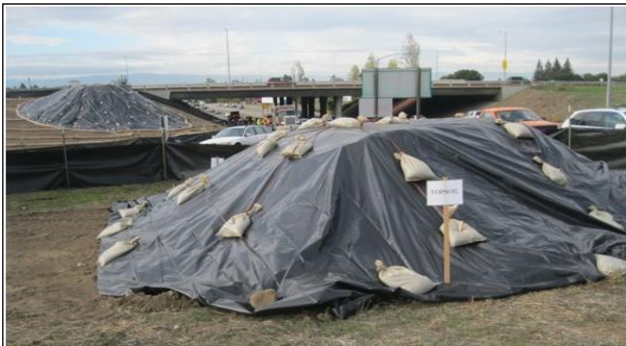
Εικόνα 8: Παράδειγμα κάλυψης μπαζών / αδρανών
